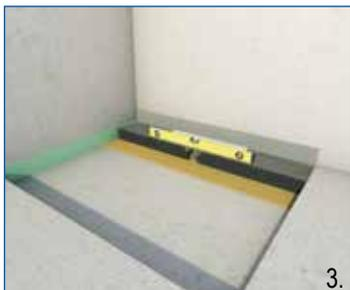
DE Duschrinne in den Klebmermortel und an die Wand setzen und waagrecht einnivellieren
